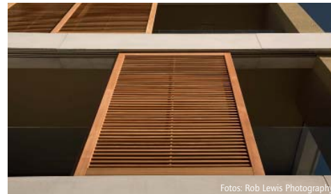
Durch das Verstellen der Läden werden die «Sonnenarena»-Bewohner zu Gestaltern der Fassade.
